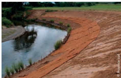
Renforcement des berges de La Douhencheur, affluent de La Nera
